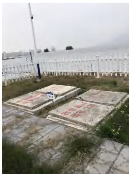
埋地密闭调节池
